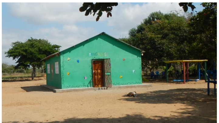
Die KITA heute, gut ein Jahr nach dem Umbau:
